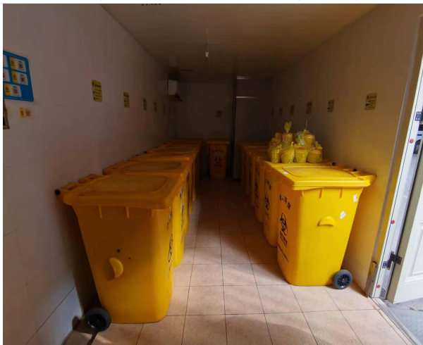
医疗废物暂存间内部现状
